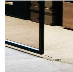
浮遊感を持たせたアンダーカット寸法
