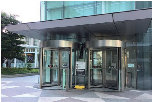
1階回転扉入口
