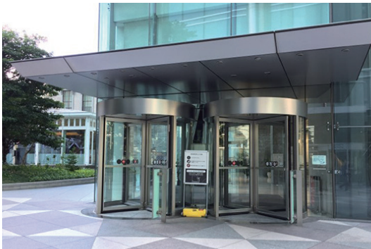
1階回転扉入口
