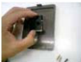
⑦ 目隠しプレート固定部品をピンを下向きにしてパネルにはめ込む
