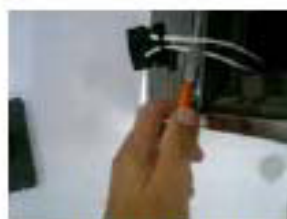
③ チャイム用配線をペンチ等で切断して接点部を外す。
