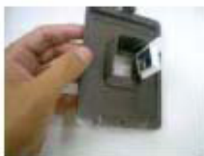
⑤ パネルに干渉防止の目隠しプレートを入れる
