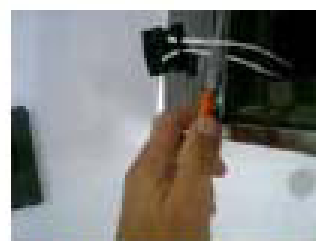
③ チャイム用配線をペンチ等で切断して接点部を外す。
