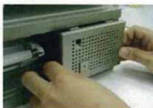
④インターホンパネルの側面から手を添えてをインターホンパネルをポストから引き出し、信号線配線(2本又は3本)を外す。
