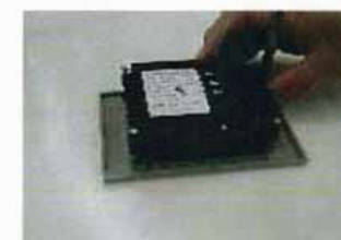
⑧インターホンパネルに新しいドアホン子器を取付け、下記配線方法に従い、信号線を配線する
