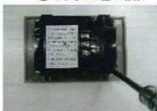
⑤インターホンパネルからドアホン子器を外す。(銀色のねじ4本で固定されています。)
