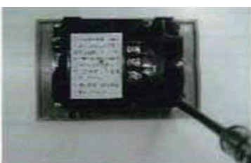
⑤インターホンパネルから ドアホン子機を外す。 (銀色のねじ4本で固定されて います。)
