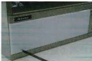
②表札板のねじ2本を外す。 (HS型の場合)
