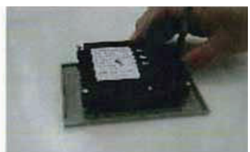
⑧インターホンパネルに新しい ドアホン子機を取り付け、 下記配線方法に従い、 信号線を配線する。
