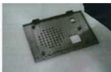
⑥インターホンパネルから ドアホン子機を外した状態です。
