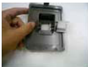
④ 押ボタンパネルからチャイム用押ボタンを外す。
