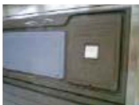
① 押ボタンパネルのねじ1本を外す。
