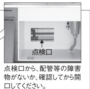
点検口から、配管等の障害物がないか、確認してから開口してください。
